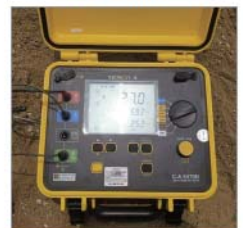
접지저항 측정 낮은 접지저항값을 나타냄
